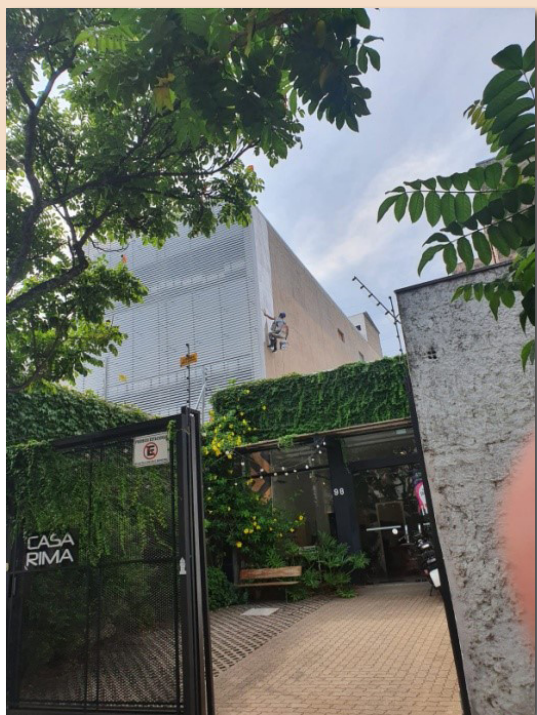
Pinturas externas na sede da federativa
