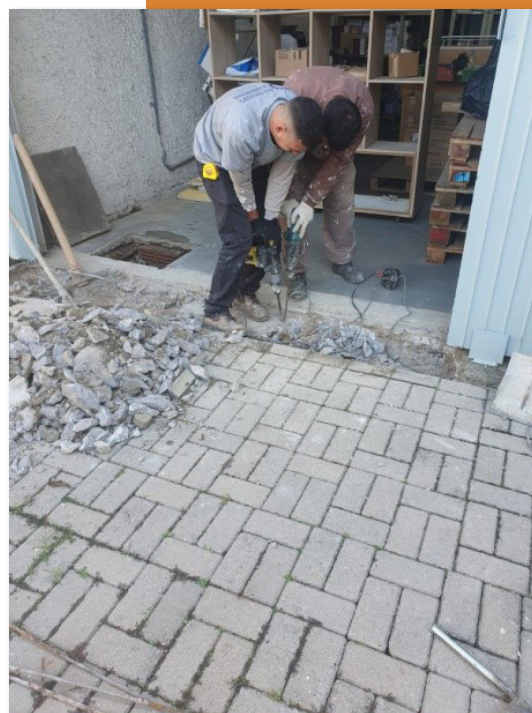
Adequação de piso na entrada do estoque
