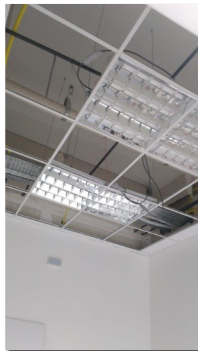
Manutenção em placas de forro mineral em diversos setores e salas da federativa
