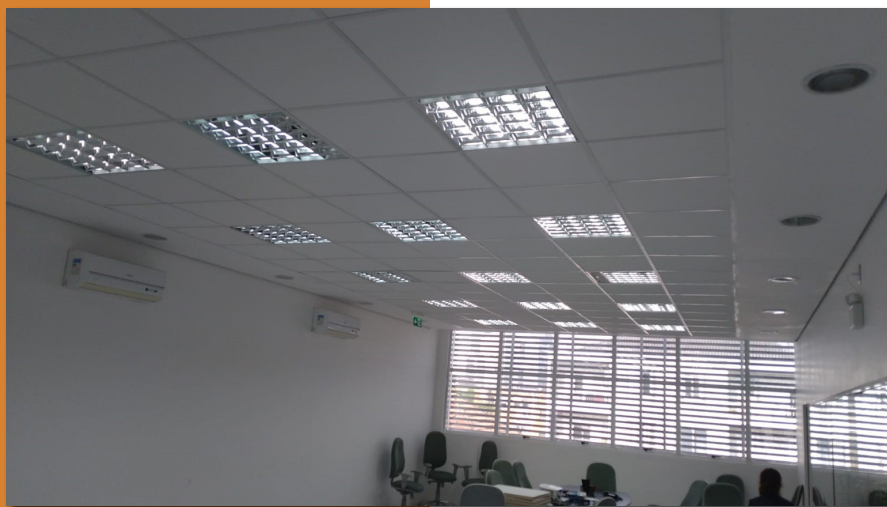
Manutenção em placas de forro mineral em diversos setores e salas da federativa
